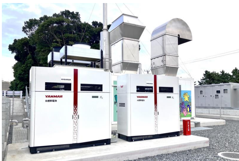
<JERA 袖ヶ浦火力発電所に設置されたヤンマーの水素発電システム>
