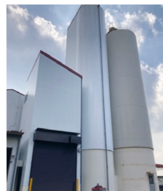
▲ 増設した荷受設備・貯留装置の外観
