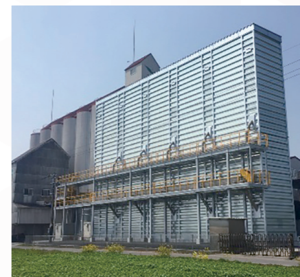
【外観:大型循環乾燥機 50t×5基】
