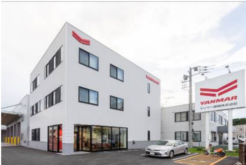
<ヤンマー建機 東京支店外観>
