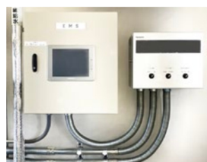
▲廃熱の最大利用を制御 (CGSコントローラー) とシステム全体の見える化 (Y-EMS)
