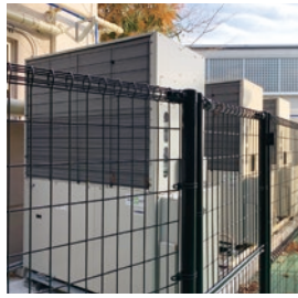
室外機設置状況
