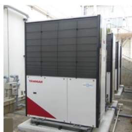
室外機設置状況
