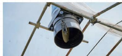
高温対策のために、ハウスの天井に「空動扇」を設置。
