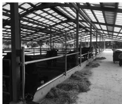
(譲り受けた牛舎を自力で改築)
